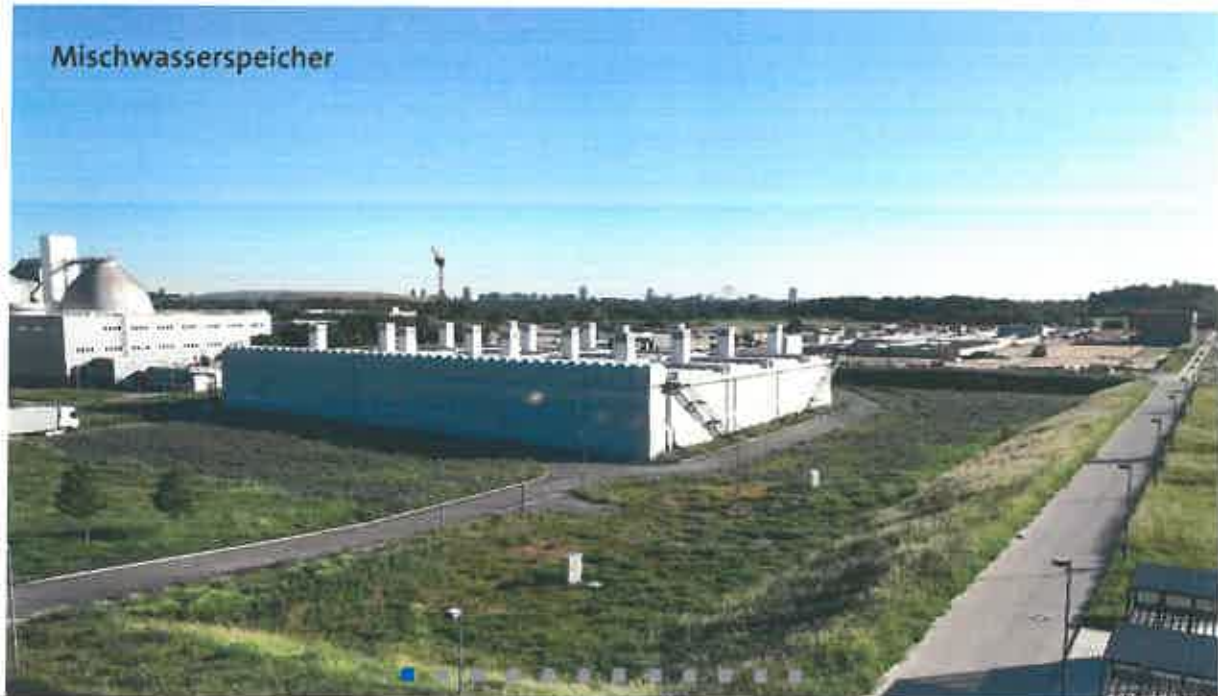
Objekt 1 Mischwasserspeicher wurde 2019 abgeschlossen und an AE übergeben
